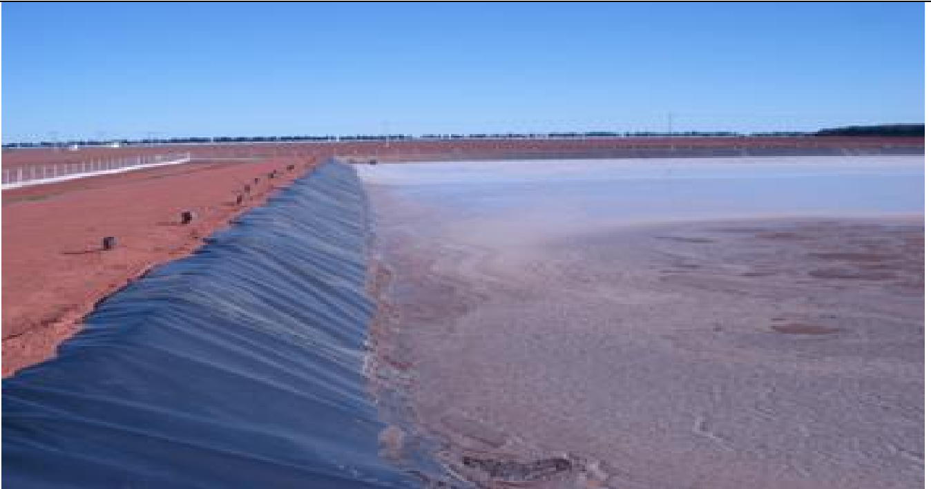
Foto 04 – Tanque de vinhaça impermeabilizado
