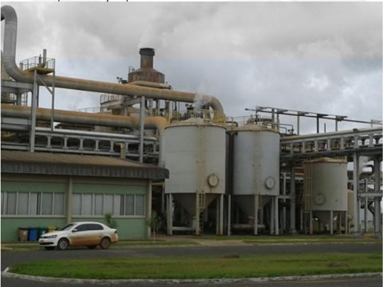
Foto 05 – Vista parcial da área industrial
