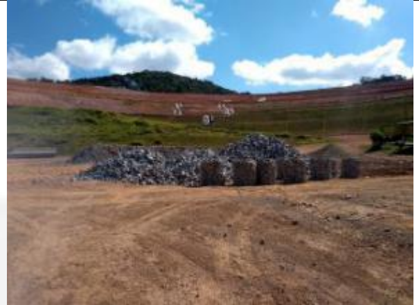
Foto 10: Unidade de aterragem em atividade em que é possível observar as medidas revegetação dos taludes inferiores, rede de drenagem pluvial em que a geomembrana de PEAD se torna aparente, e dutos de gases em preparação para instalação no pátio inferior.
