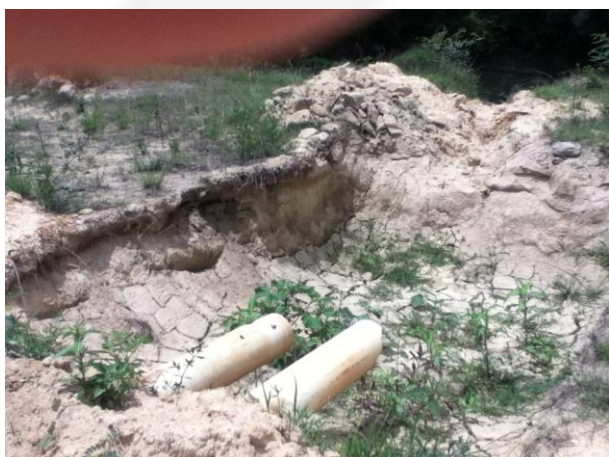
Foto 07. Bacia de decantação (porto B)
