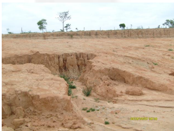
Foto 03. Processo erosivo na cava B
