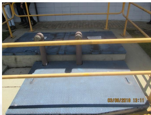
Contenção localizada em área externa à Central
