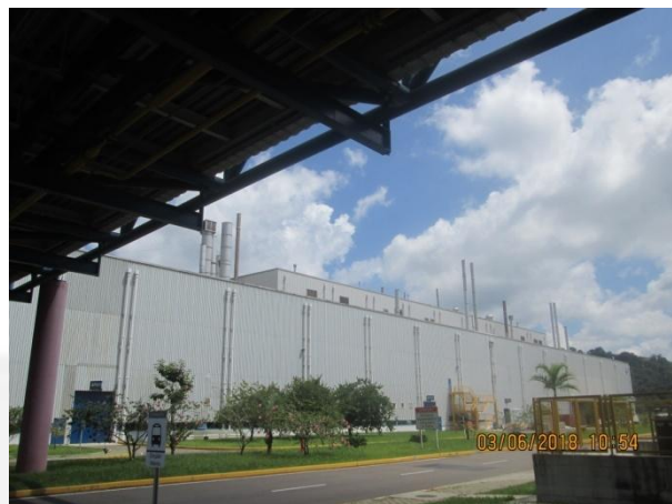
Chaminés do setor de pintura
