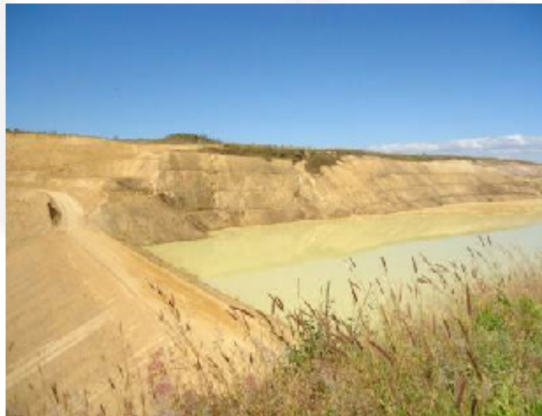
Figura 4: Vista parcial da Barragem de Rejeitos.
