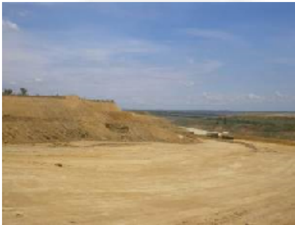
Foto 01. Área de implantação da expansão da cava "C"
