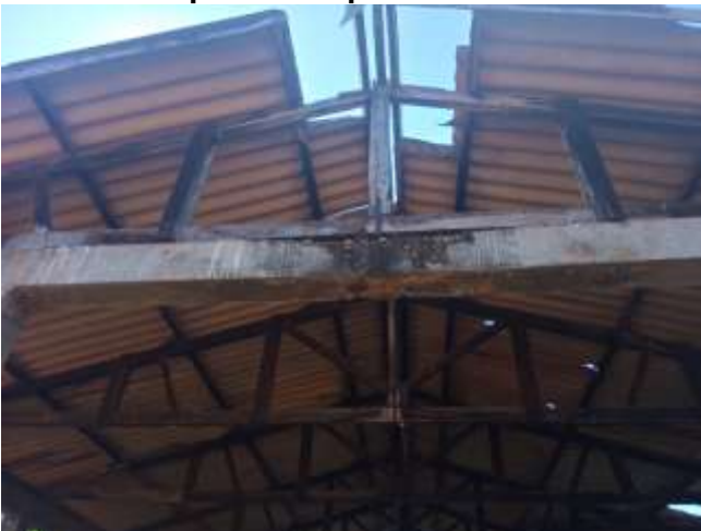
Telhas e madeiramento danificados alguns
