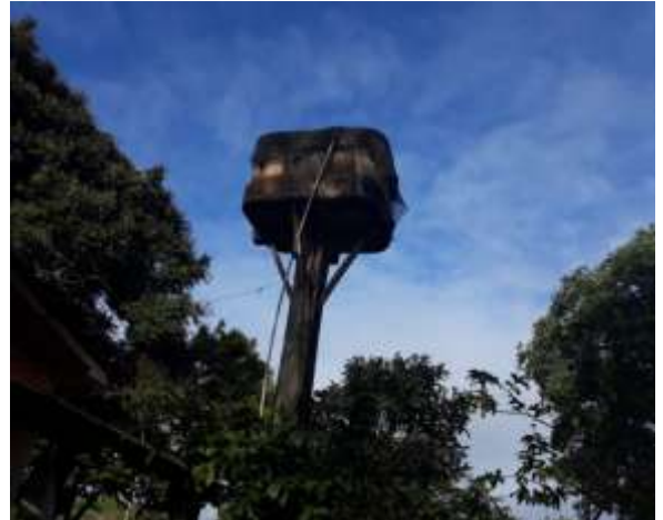
Substituição de caixa d'água
