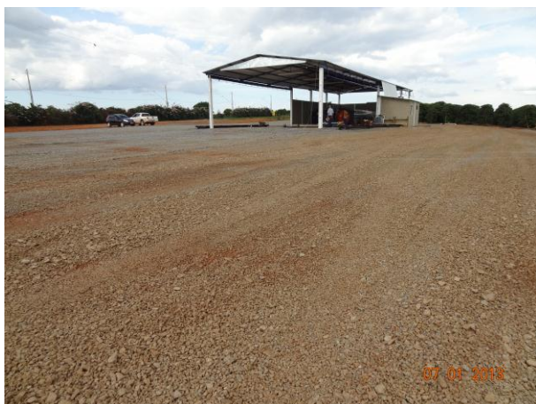
Foto 5. Entorno do galpão coberto por brita
