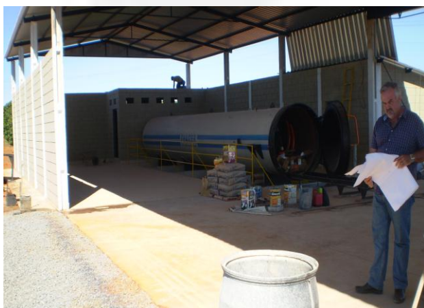
Foto 1. Vista frontal do galpão
