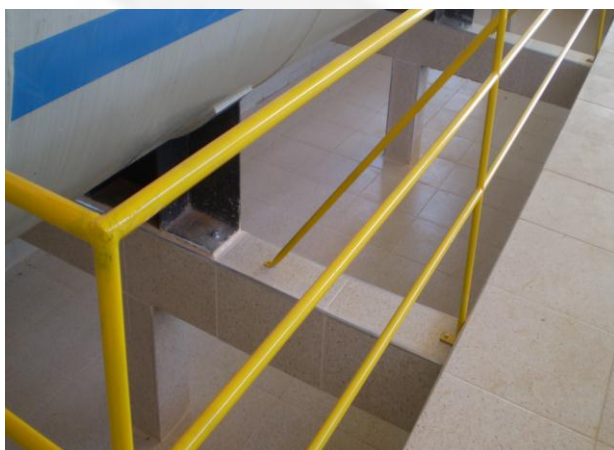
Foto 3. Bacia de contenção da autoclave
