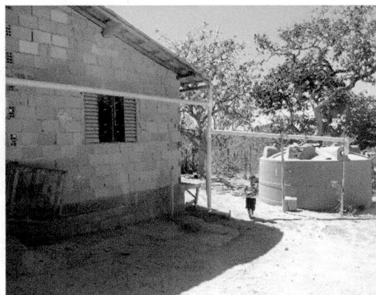
Foto 17. Caixa de captação de água pluvial
