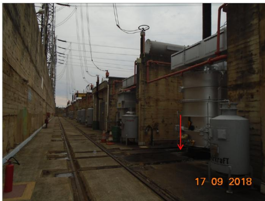
Figura 14 - Bacias de contenção dos transformadores.
