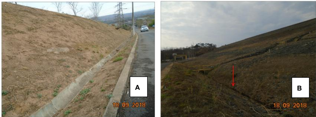
Figura 17 – Sistema de drenagem de água pluvial ao longo das vias de acesso da usina (A) e Caneleta de drenagem de águas pluviais ao longo do barramento (B)
