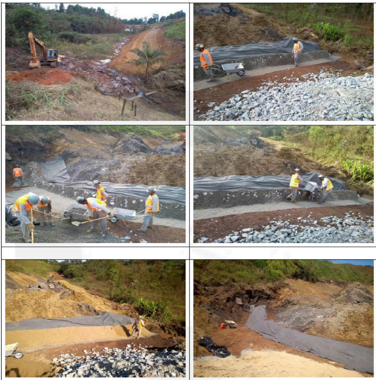
Etapas de construção/conclusão do dreno da ampliação da PDR
