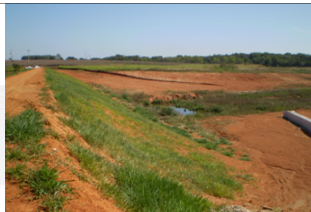
Foto 02: Vista do barramento - jusante
