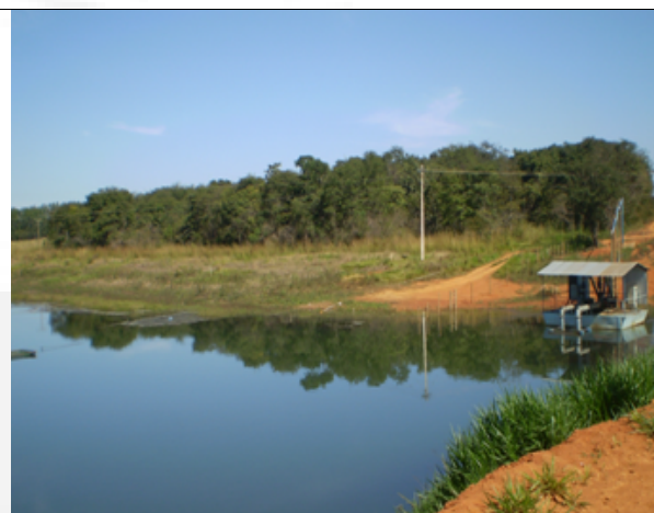
Foto 06: Vista a montante do barramento – margem esquerda
