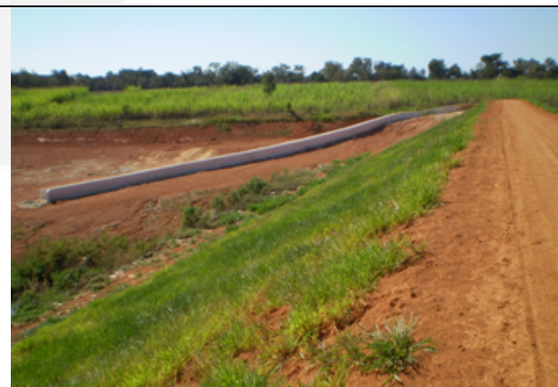
Foto 04: extravasor a direita do barramento
