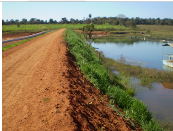
Foto 09: talude revegetado tanto a montante quanto a jusante.
