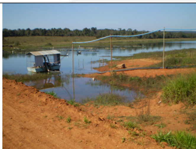
Foto 07: Captação superficial da fazenda das Flores
