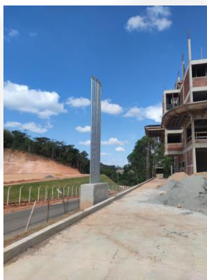
Foto 7: Respiro dos tanques localizados em local aparente e distante de edificações.
