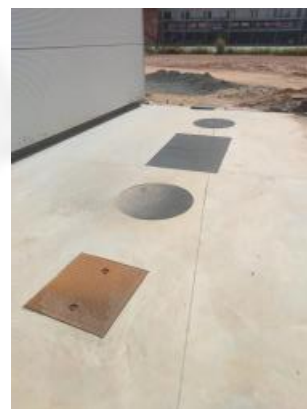
Foto 8: Caixa separadora de água e óleo.
