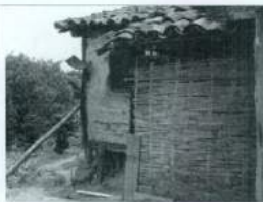
Figura 30 -Edificação de Adão Bento de Souza com parede de esteira de taquara feita pelo morador. Foto Digital – Jan. 2013. Fonte: Luana Carla Martins Campos.
