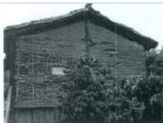
Figura 29 -Estrutura de pau a pique da moradia Adão Bento de Souza. Foto Digital – Jan. 2013. Fonte: Luana Carla Martins Campos.
