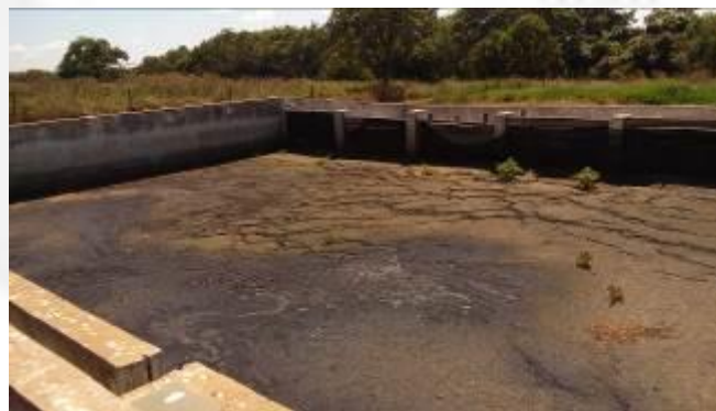
Imagem 02. Tanque em alvenaria de armazenamento de dejetos da suinocultura.
