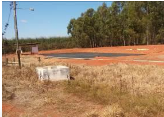
Imagem 03. Tanque escavado no solo para de armazenamento de dejetos da suinocultura.
