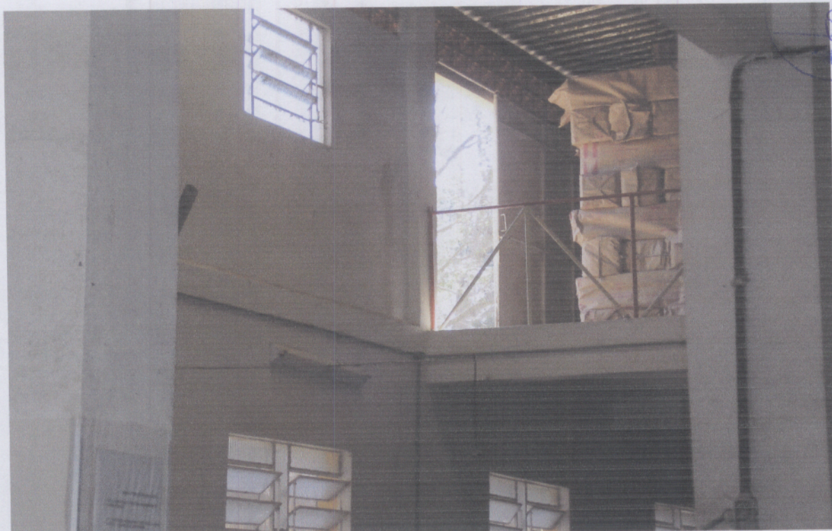
Vista interior depósito de embalagens com ventilação Granja São Geraldo 02/06/06.
