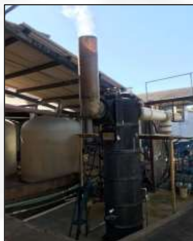
Figura 4: Neutralização do vapor ácido com solução alcalina com saída para atmosfera de vapor d'água (com bacia de contenção).
