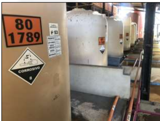
Figura 3: Tanques de armazenamento de produtos químicos com bacia de contenção.
