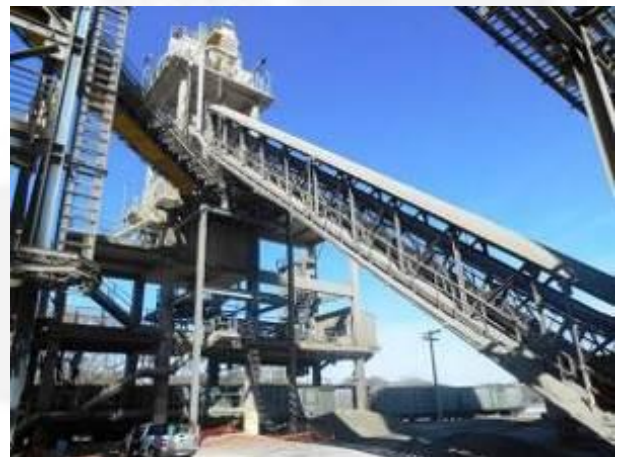
Foto 04. Correia para transporte e carregamento do clínquer excedente nos vagões.
