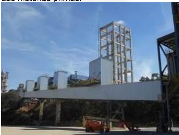
Foto 07. Sistema pneumático para transporte do cimento à área de expedição e ensacamento.
