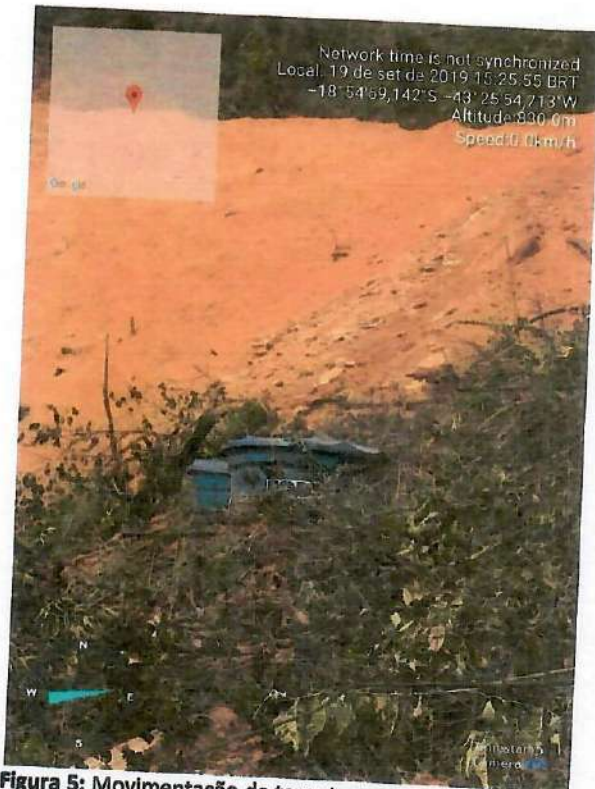
Figura 5: Movimentação de terra inerente à abertura da via imediatamente à montante das duas caixas d'água que compõe o sistema de abastecimento de água de 4 residências do Gondó. Fotografia obtida por Letícia Oliveira em 19/10/2019.
