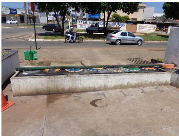
Foto 03. Área de descarga de combustível
