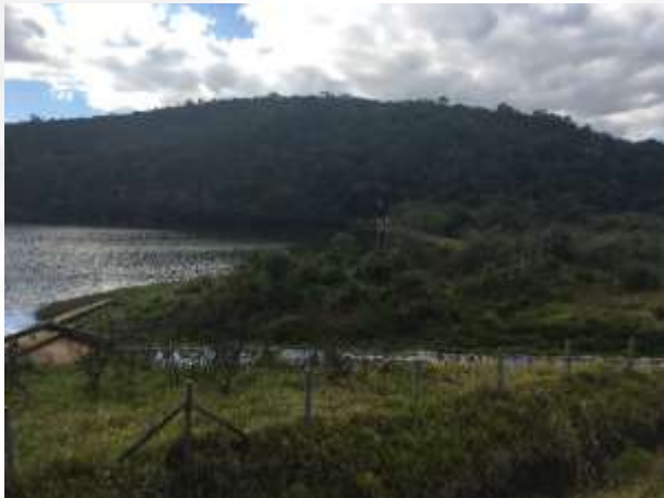
Foto 03. Represa de São Pedro, manancial, no local de captação
