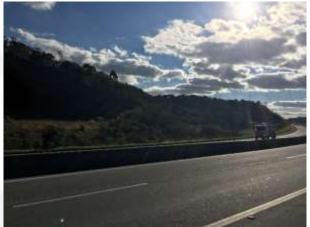
Foto 04. BR-040 no contato com a estrada a ser construída
