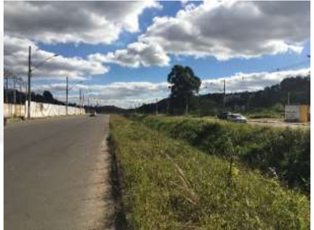
Foto 02. Trecho já construído, com retificação do curso d'água
