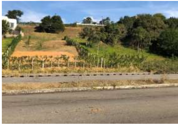
Figura 2: Estruturas implantadas de drenagem superficial. Fonte: SUPPRI, 2018.
