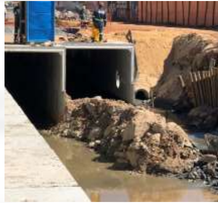
Figura 3: Canalização em curso e canais de escoamento de esgoto em paralelo. Fonte: SUPPRI, 2018.
