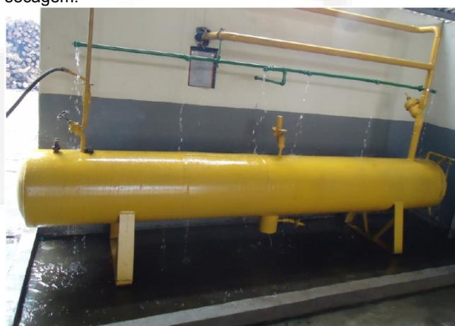
**Foto 06.** Tanque de armazenamento do gás amônia e as instalações do chuveiro e bacia de contenção para controle de possíveis vazamentos.
