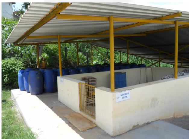
**Foto 05.** Local de armazenamento de bombonas e tambores com material retirado de ETE e leito de secagem da gordura removida na ETE.
