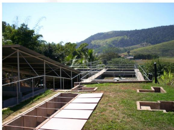
**Foto 04.** Vista geral da ETE (tanque preliminar, tanque de equalização, tanque de aeração, decantador e leito de secagem).
