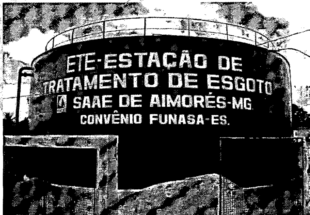
Foto 02: Conjunto Reator Anaeróbio (anel externo) e Filtro Biológico (anel interno)
