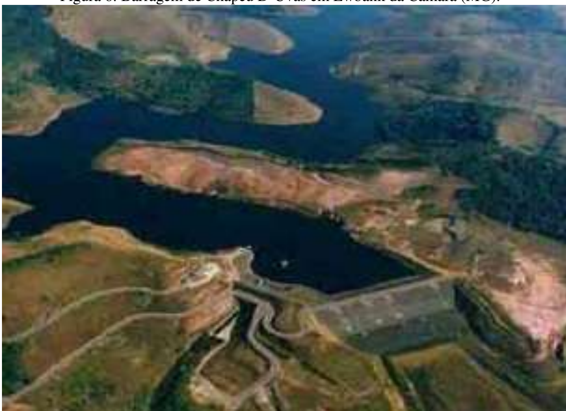
Figura 6: Barragem de Chapéu D'Uvas em Ewbank da Câmara (MG).
