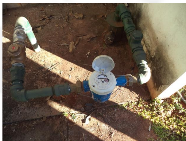
Foto 04. Poço tubular com hidrômetro.
