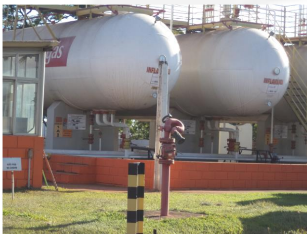
Foto 01. Tanques de armazenamento de GLP.
