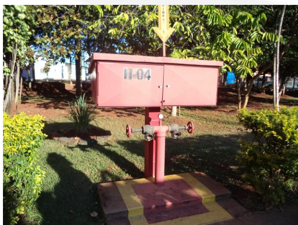
Foto 09. Hidrante de combate a incêndio.
