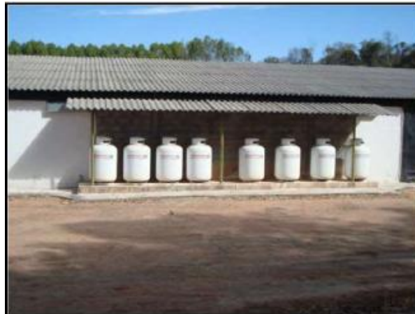
Foto 04. Armazenamento do gás GLP (aquecimento dos pintainhos).
