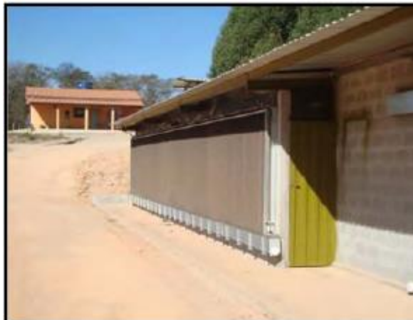
Foto 01. -Lateral do galpão--
