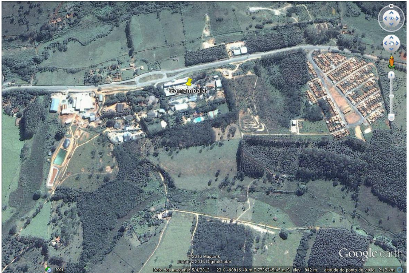
Foto 12 – Vista geral da empresa e de seu entorno
