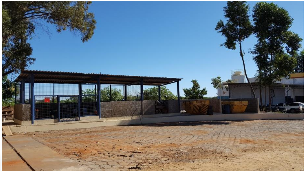
Depósito de armazenamento temporário de resíduos sólidos, classe I e II.
