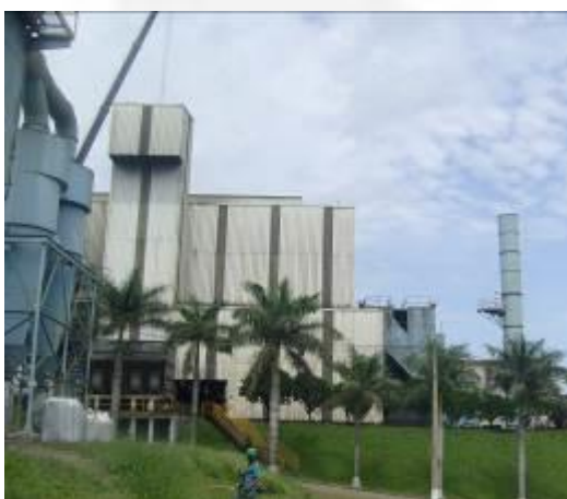
Foto 09. Condições de lançamento dos efluentes atmosféricos
