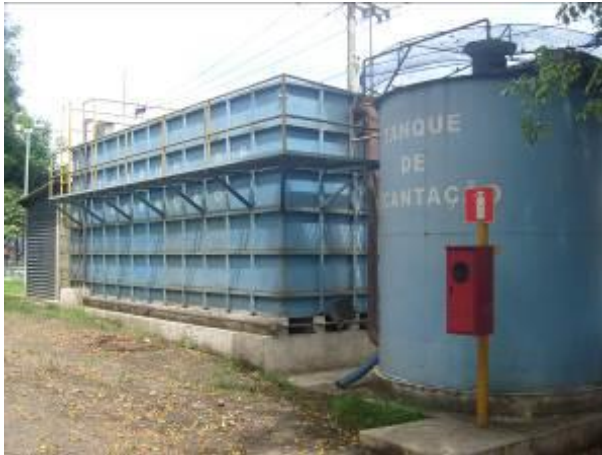
Foto 05. Tanque de decantação
