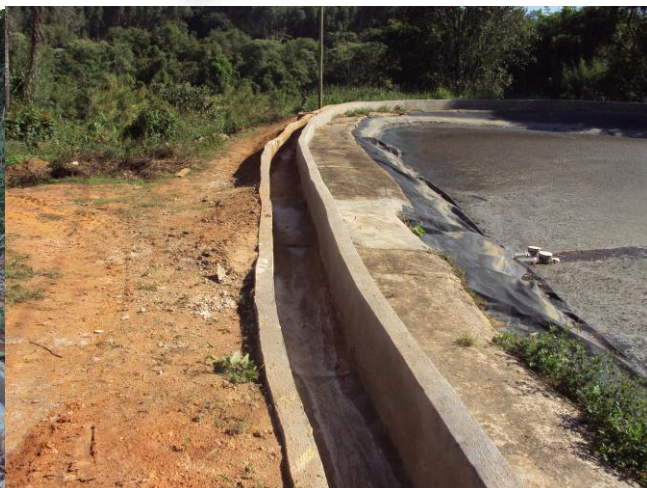
- Drenagem pluvial no entorno das lagoas
