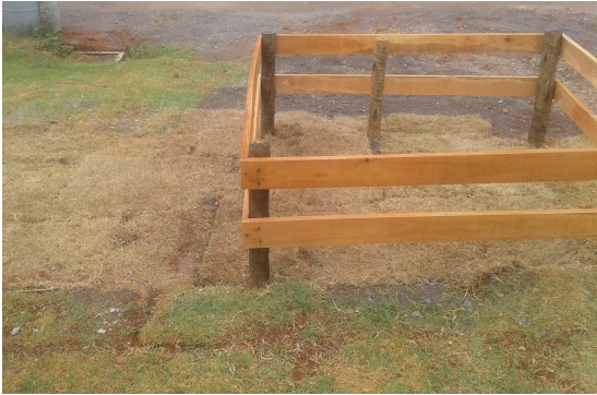
Foto 05. ETE Sanitária - Sistema Biodigestor
