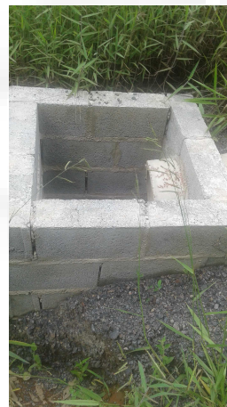
Foto 04. Caneletas de drenagem de água pluvial
