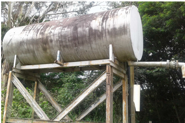
Foto 03. Caixa d'água que abastece caminhão pipa para umectação das vias
