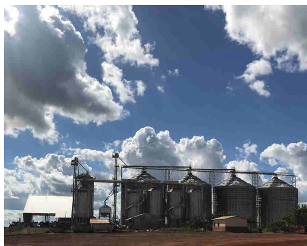
Foto 04. Silos de armazenamento
