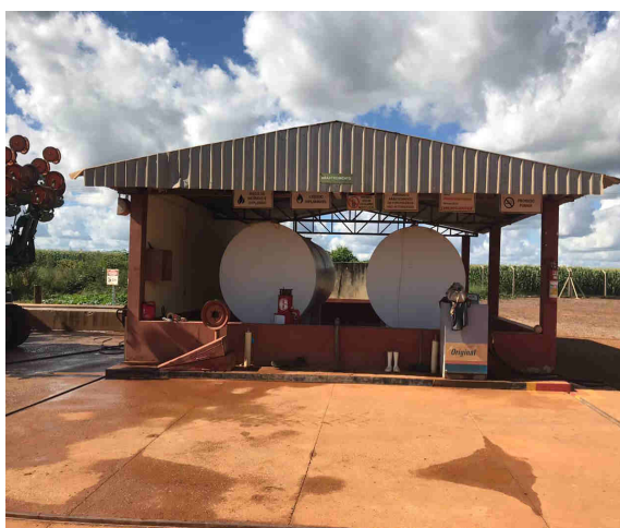
Foto 03. Ponto de abastecimento
