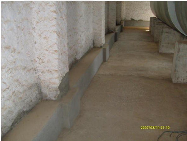
Foto 07. Bacia de Contenção
