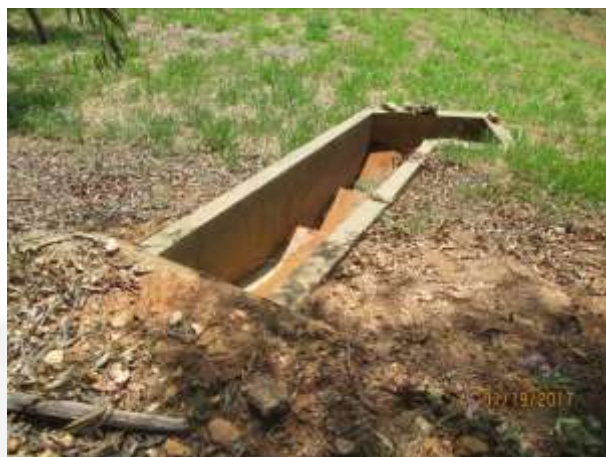
Fig. 12– Canaletas de condução de águas pluviais nas encostas dos jardins, e bocas de lobo para condução das águas pluviais.
