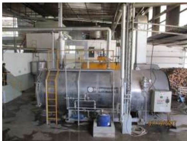
Fig. – Caldeiras movidas a lenha do empreendimento, sendo a caldeira demonstrada na imagem, no lado direito, utilizada como reserva para emergências
