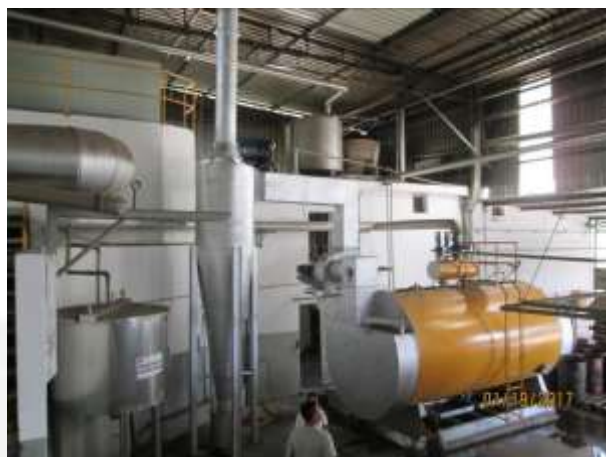
Fig. – Caldeiras movidas a lenha do empreendimento, sendo a caldeira demonstrada na imagem, no lado direito, utilizada como reserva para emergências
