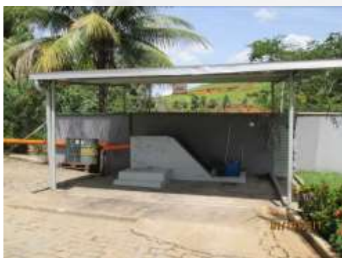
Fig. – Peneira receptora dos efluentes industriais.
