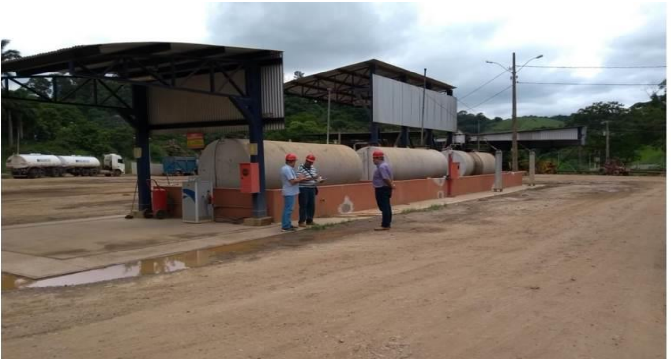
Figura 3: Posto de abastecimento.
