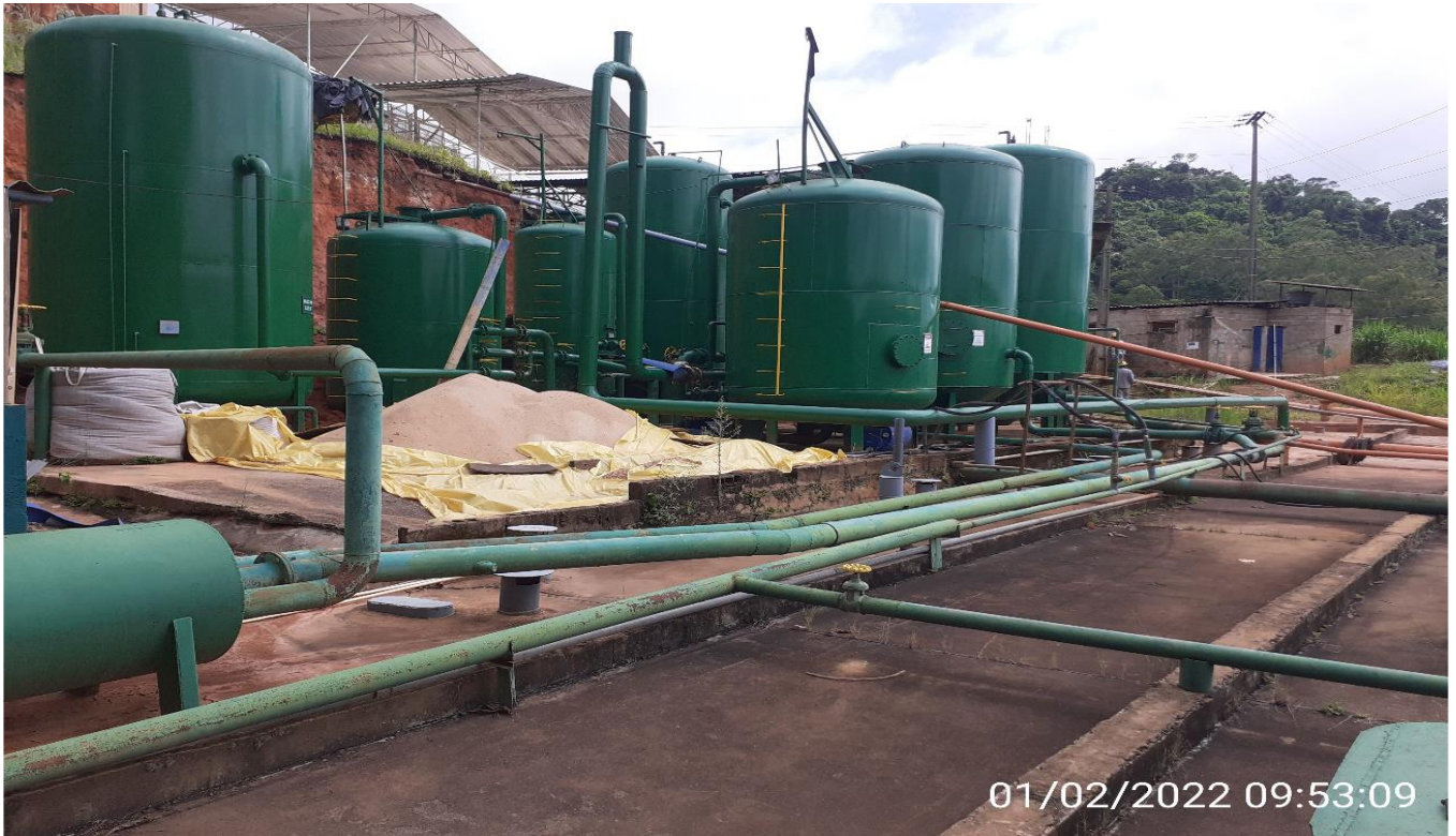
Figura 7: Vista geral da ETA, localizada em cota mais elevada do terreno.
