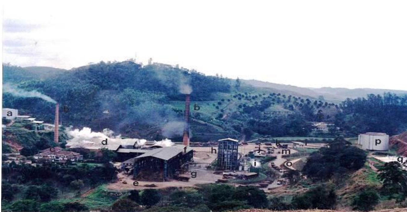
Figura 1: Panorâmica da CIA Agrícola Pontenovense/Usina Jatiboca, destacando: a- Depósito de melaço; b- Chaminé; c- Residência; d- Fábrica de açúcar; e- Depósito de cana; f- Moendas; g- Pátio de descarga de cana; h- Destilaria; i- Torres de refrigeração; j- Escritório industrial; k- Balança; l- Oficina mecânica; m- Amostragem de cana; n- Ribeirão Bandeiras; o- Via de acesso para cidade de Urucânia; p- Depósito de álcool; q- Tanque de spray.
