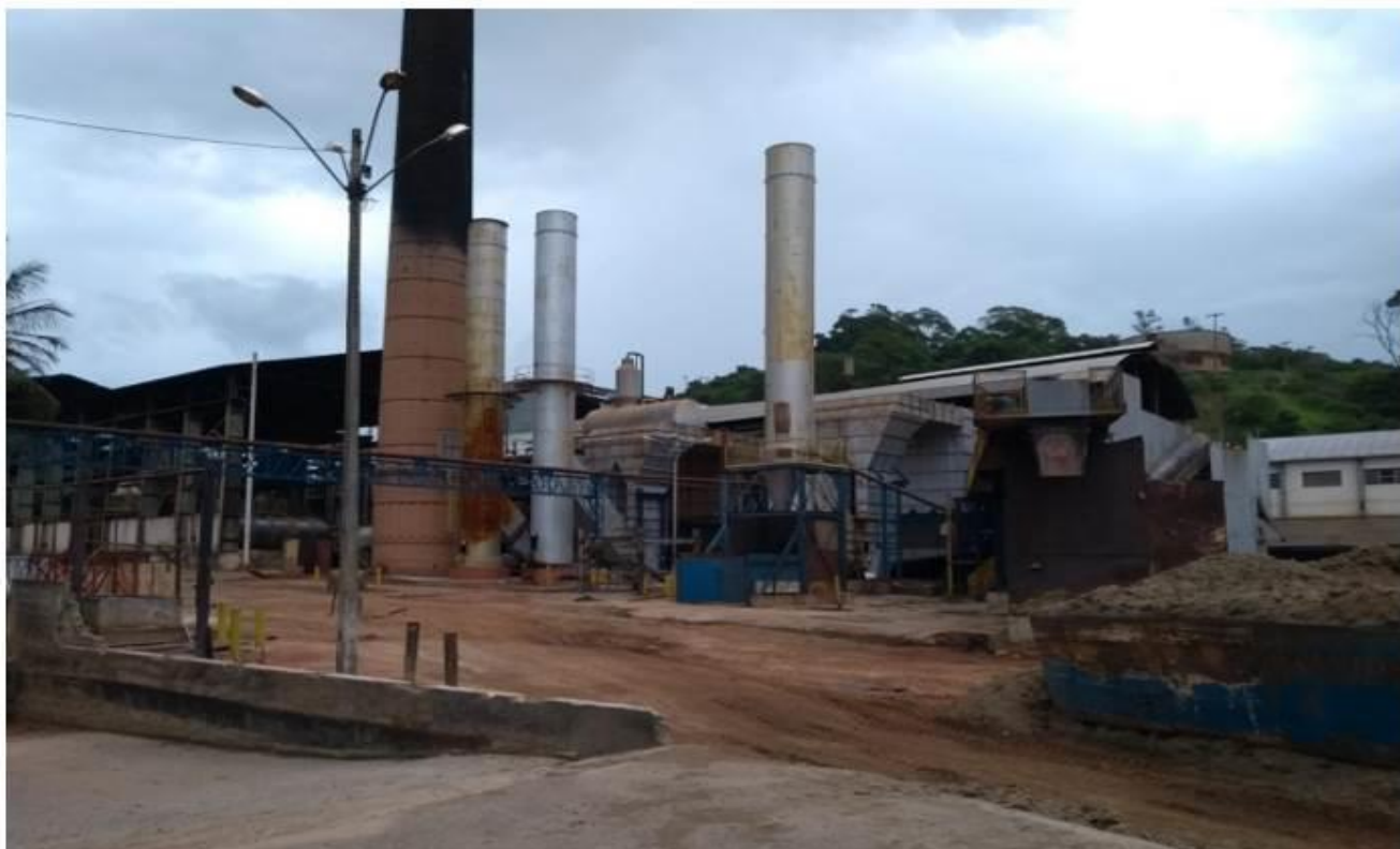
Figura 5: vista externa da estrutura que abriga as turbinas.
