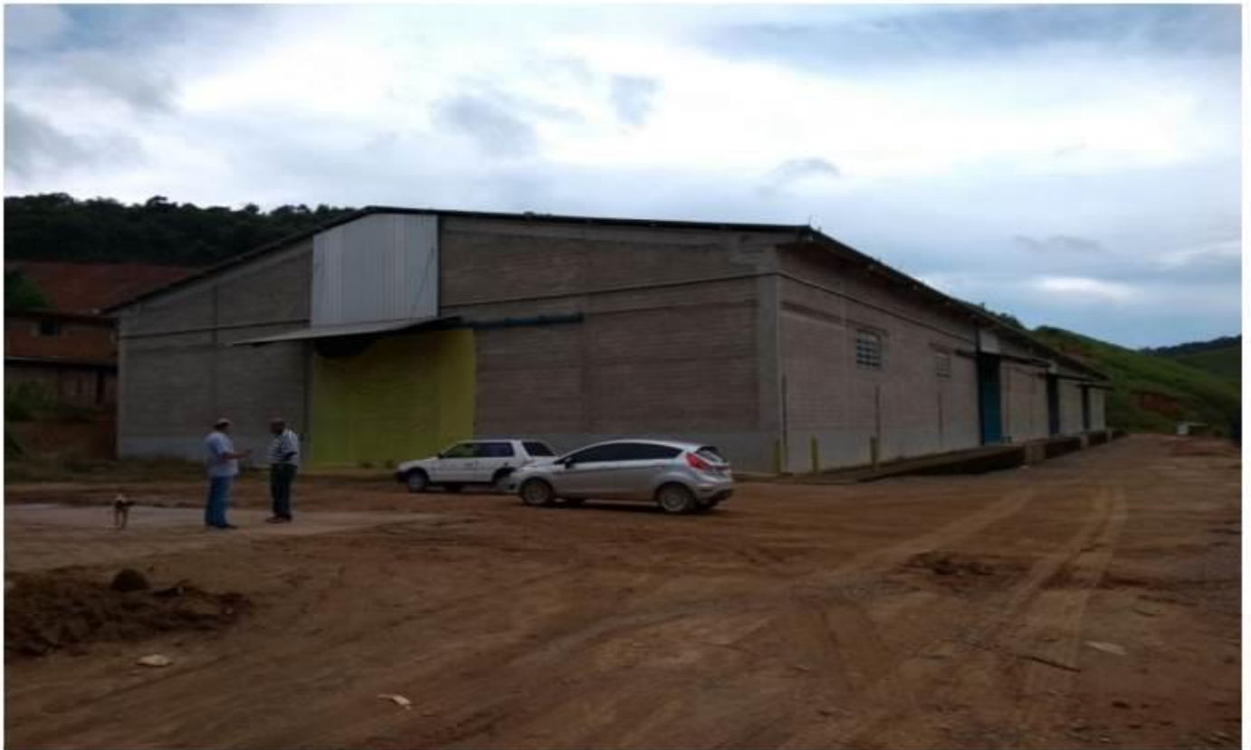
Figura 9: Galpão para estocagem de açúcar.
