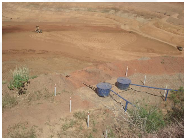
Sistema de tratamento de efluentes – Filtros de carvão ativados
