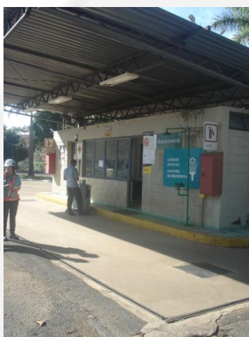
Posto do Escritório Central – Vale Tapira
