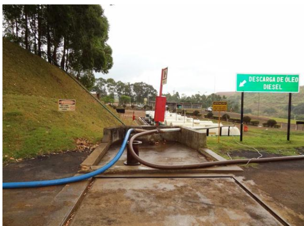
Área de descarga de Combustível – Posto da Mina (Fonte: Vale Tapira, 2013)
