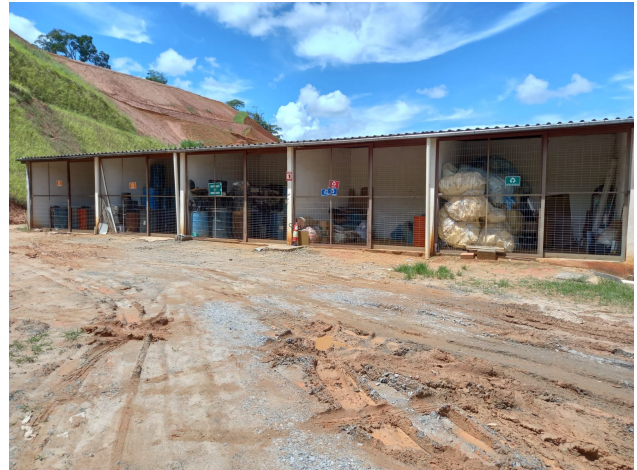
Foto 04: Galpão de depósito temporário de resíduos sólidos.
