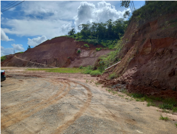
Foto 01: Parte da área onde será instalado novo galpão industrial e novo talude de corte formado e desprovido de vegetação.
