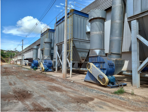
Foto 05: Armazenamento do material particulado advindo do sistema de exaustão.
