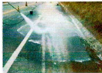
Hidrojetamento das áreas atingidas.
