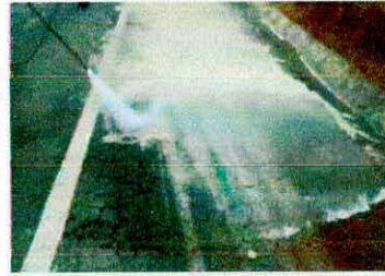
Hidrojetamento e sucção do material residual.
