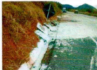
Limpeza do local.
