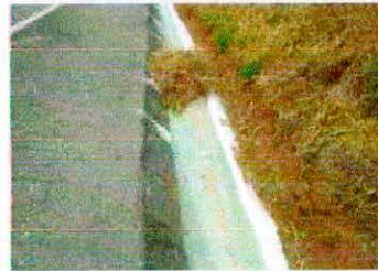
Limpeza do local.
