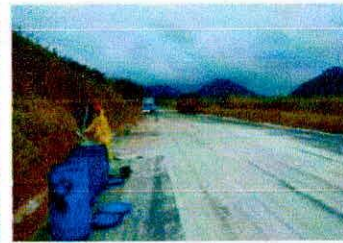
Limpeza do local.
