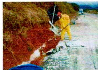
Limpeza do local.
