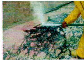
Hidrojetamento das áreas atingidas.
