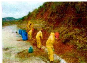
Limpeza do local.
