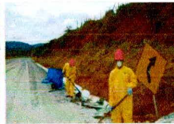
Limpeza do local.
