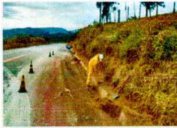
Limpeza do local.
