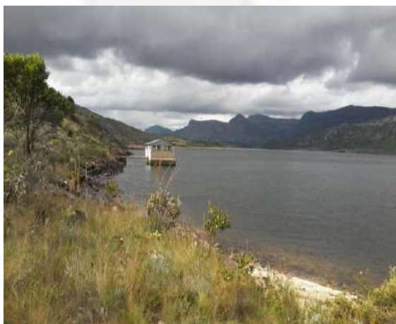
Figura 03: Tomada d'água Fonte: PCA/RCA, 2015.
