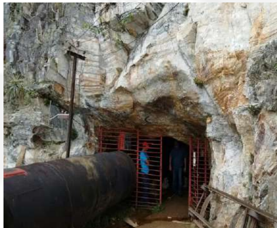
Figura 04: entrada d Túnel Fonte: PCA/RCA, 2015.
