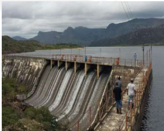
Figura 02: vertedouro Fonte: PCA/RCA, 2015
