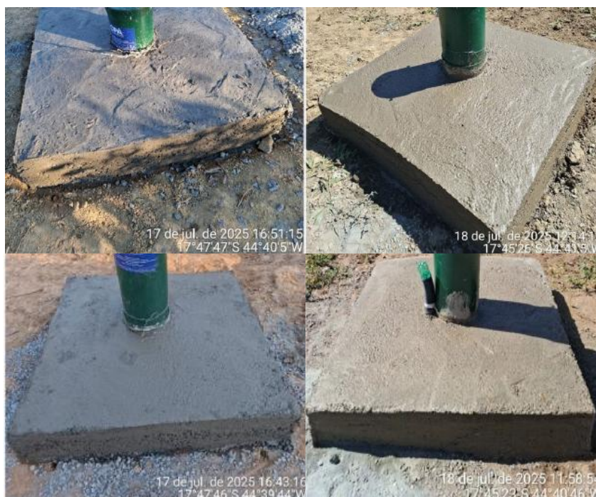
Figura 1: Evidência das lajes sanitárias (página 11 do recurso)
