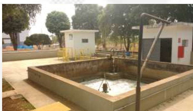
Foto 4 – Estação de Tratamento de efluentes
