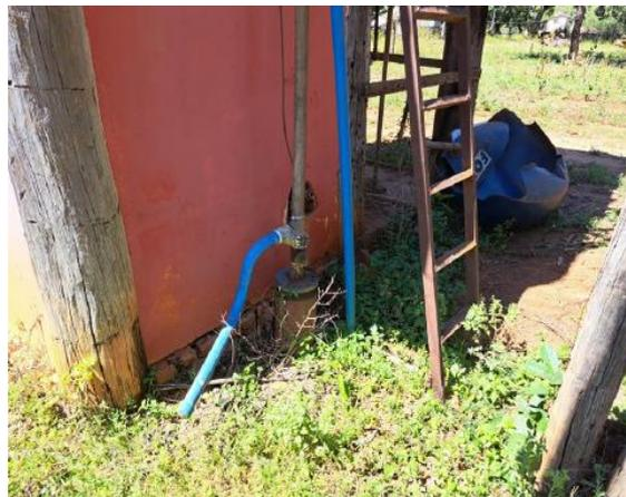
Figura 02: Poço tubular sem sistemas de medição e laje sanitária. Fonte: URA NM, 2023.
