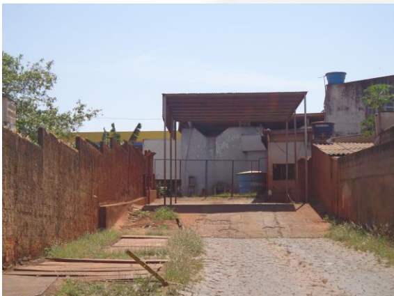
Foto 01. Área de lavagem de caminhões.
