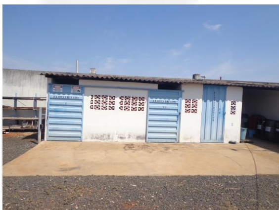
Foto 03. Almojarifado para armazenamento de produtos químicos para laboratório.
