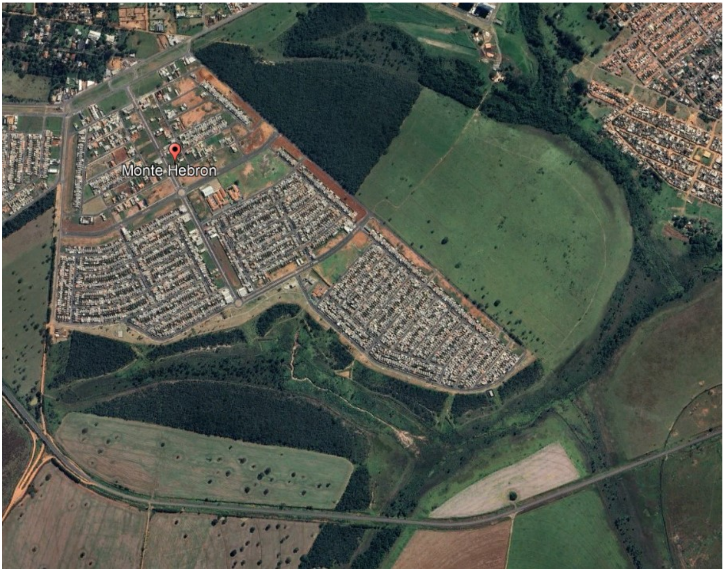
Figura 1: Imagem de todo o empreendimento Monte Hebron. (Fonte: Google Earth Pro)
