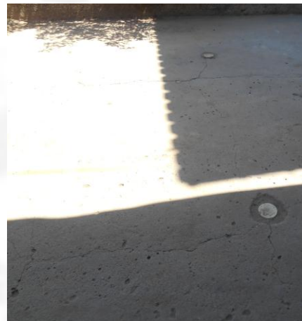
Figura 14: Fossa Séptica instalada
