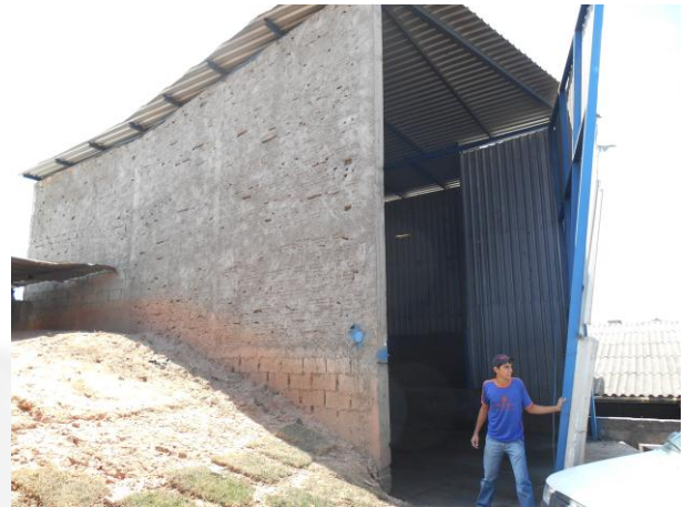
Figura 06: Vista externa depósito para resíduos siderúrgicos.
