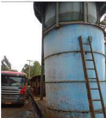
Foto 05. Estruturas e vias existentes na
