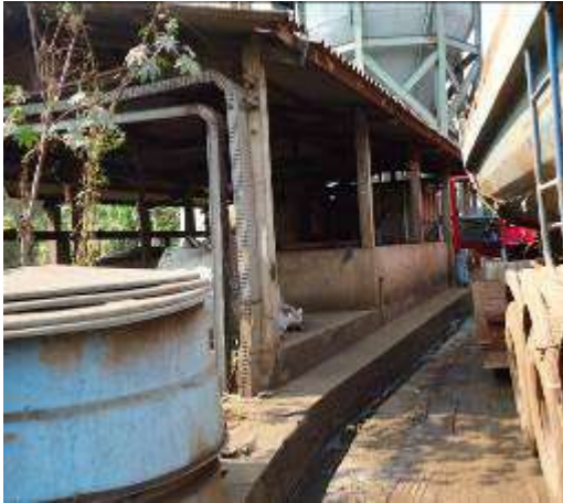
Foto 07. Estruturas e vias existentes na APP.
