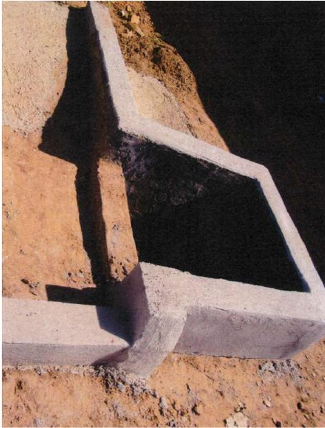
**Foto 05.** Caixa de decantação da drenagem pluvial.
