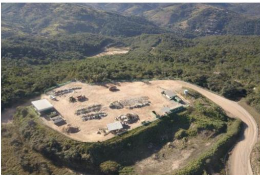
Foto 23. Vista geral – ATT RCC
