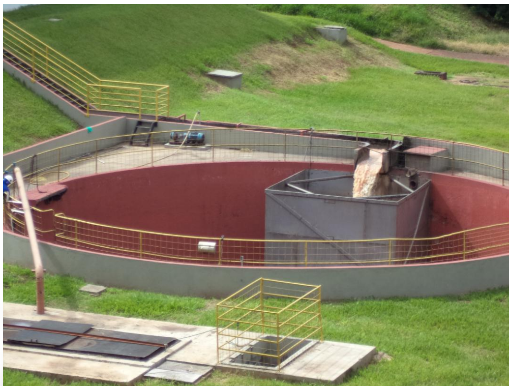
Melhoria na saída da canaleta de efluentes industriais efetuada para redução da emissão de odores
