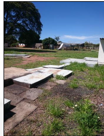
Figura 6: Tratamento de Efluentes: Fossa Séptica e Caixa SAO.
