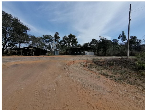
Foto 10: Galpão de Resíduos
