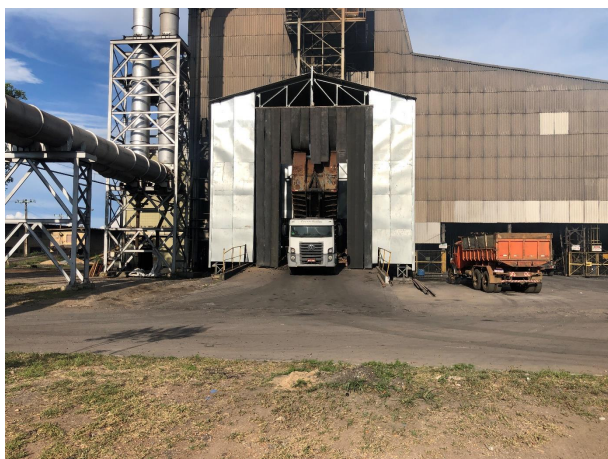
Foto 5: Galpão de Carregamento do Skip
