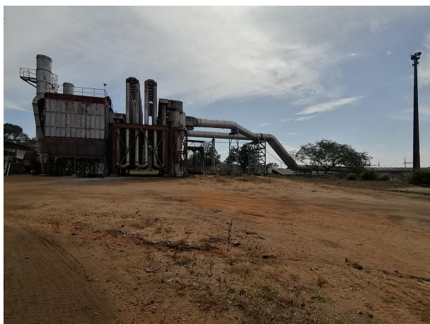
Foto 7: Despoeiramento dos Fornos 1 e 2
